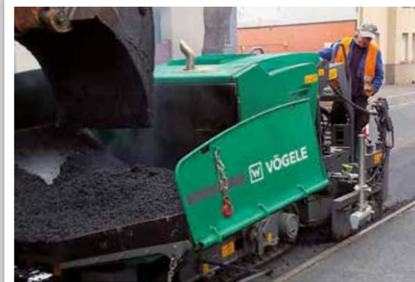
PAVING ASPHALT BETWEEN TRAMWAY TRACKS
