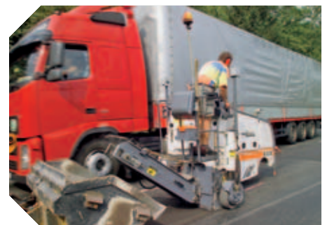
Fresagem com trânsito ininterrupto ▲
