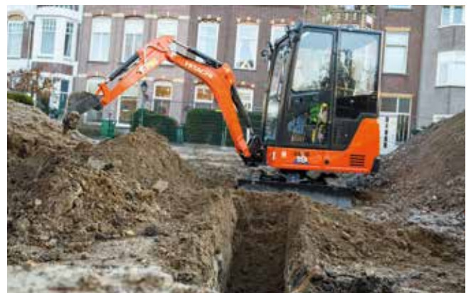
O cilindro na parte superior da lança está bem protegido.
